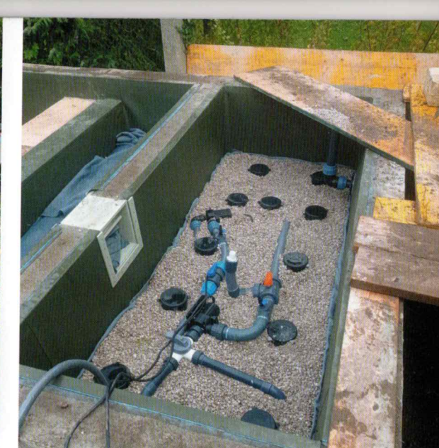
▲ Damit später das Wasser so fließt, wie es soll, ist beim Filteraufbau große Sorgfalt vonnöten.
