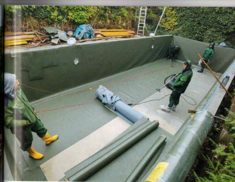
▲ Arbeit für Profis: Die Folie muss glatt und dicht ins Becken. Hier wird die Grundlage für den Badespaß kommender Jahrzehnte gelegt.
